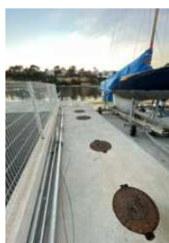
Emplacement du séparateur d'hydrocarbure
