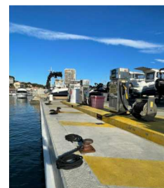
Linéaire du quai d'accostage
