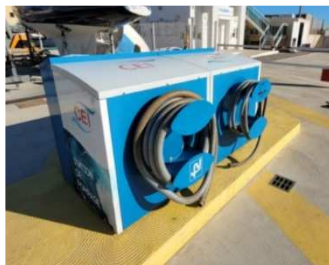
Station de pompage pour eaux usées (pompe eau grises et pompe eaux noires)
